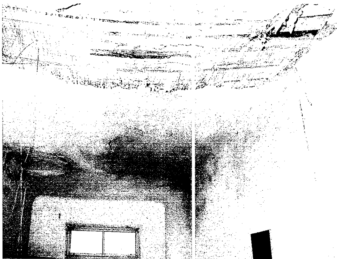
Foto 5 - Săgeți exagerate ale gri izilor din lemn din planșeu
